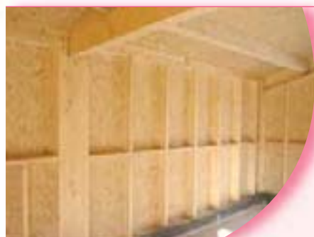
Murs à ossature bois
