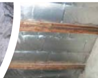
Chevrons masqués par un isolant
