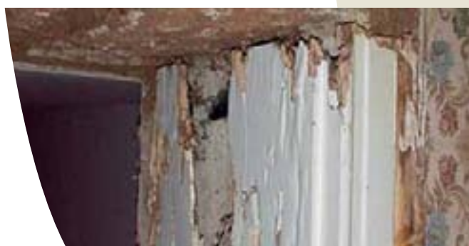
Attaques sur un montant de porte
