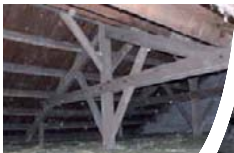
Charpente en combles perdus
