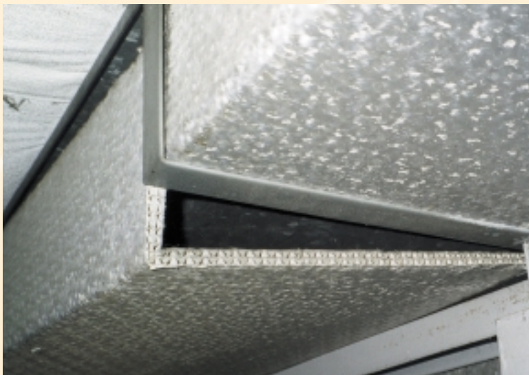
Utilisation de plaques cartonnées pour une gaine.
